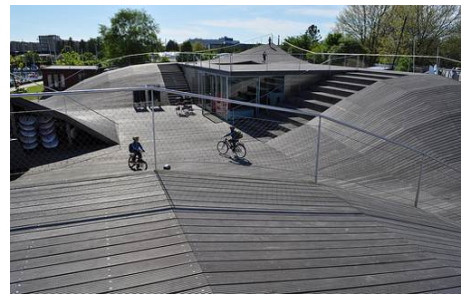
Club nautic cu depozitare de barci, al cărui acoperis este în întregime placat cu lemn – deck în forme curbe, cu pante și trepte pentru jocul copiilor, care poate fi traversat și cu bicicleta.
